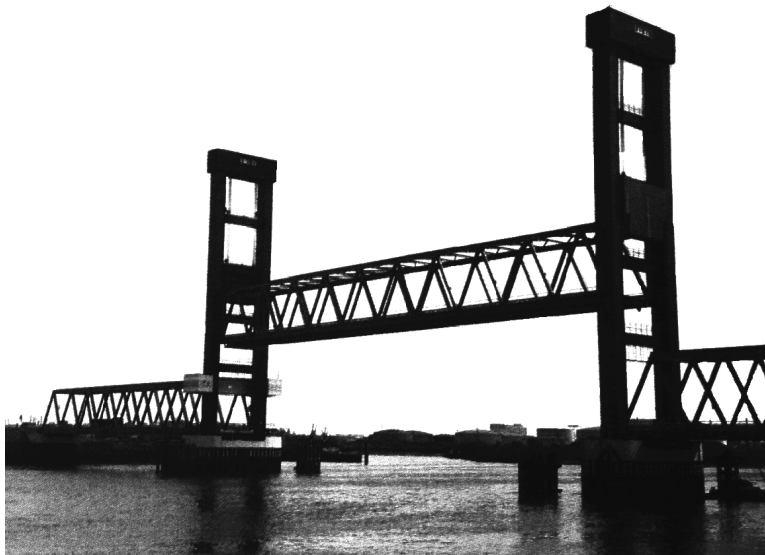
Kattwyk-Hubbrücke über die Süderelbe (aus Chronik der Technik, Chronik Verl.)
